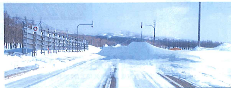
吹きだまり状況調査
